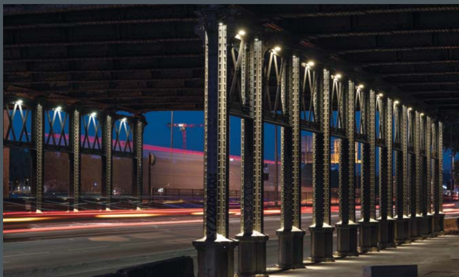
Viaduc SNCF Lyon Perrache
